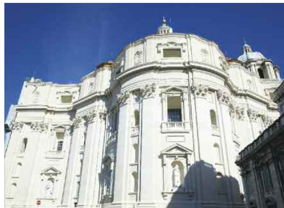
Basilica S. Pietro prospetto sud (terzo lotto) dopo il restauro
